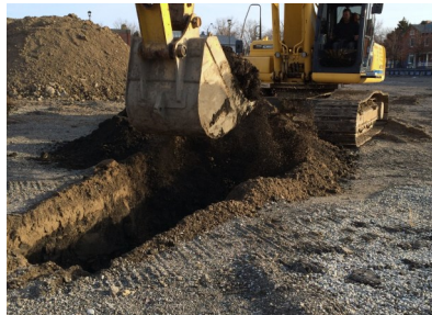
Fig. 1— Digging test pit
